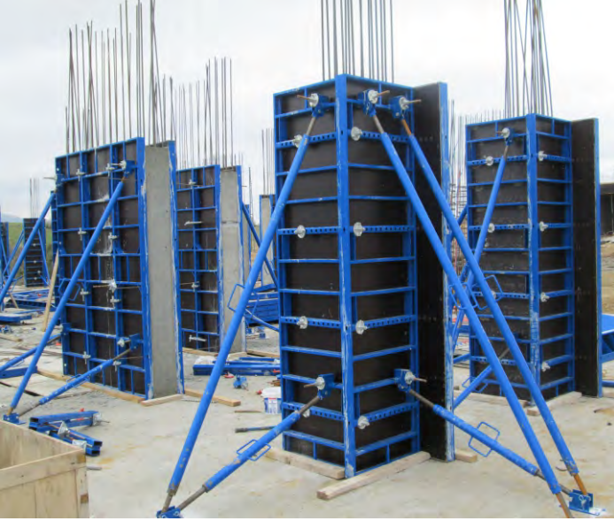
Ayarlanabilir hafif panoları sayesinde farklı boyutlardaki kolon ve perdelerin imalatına olanak tanır.
